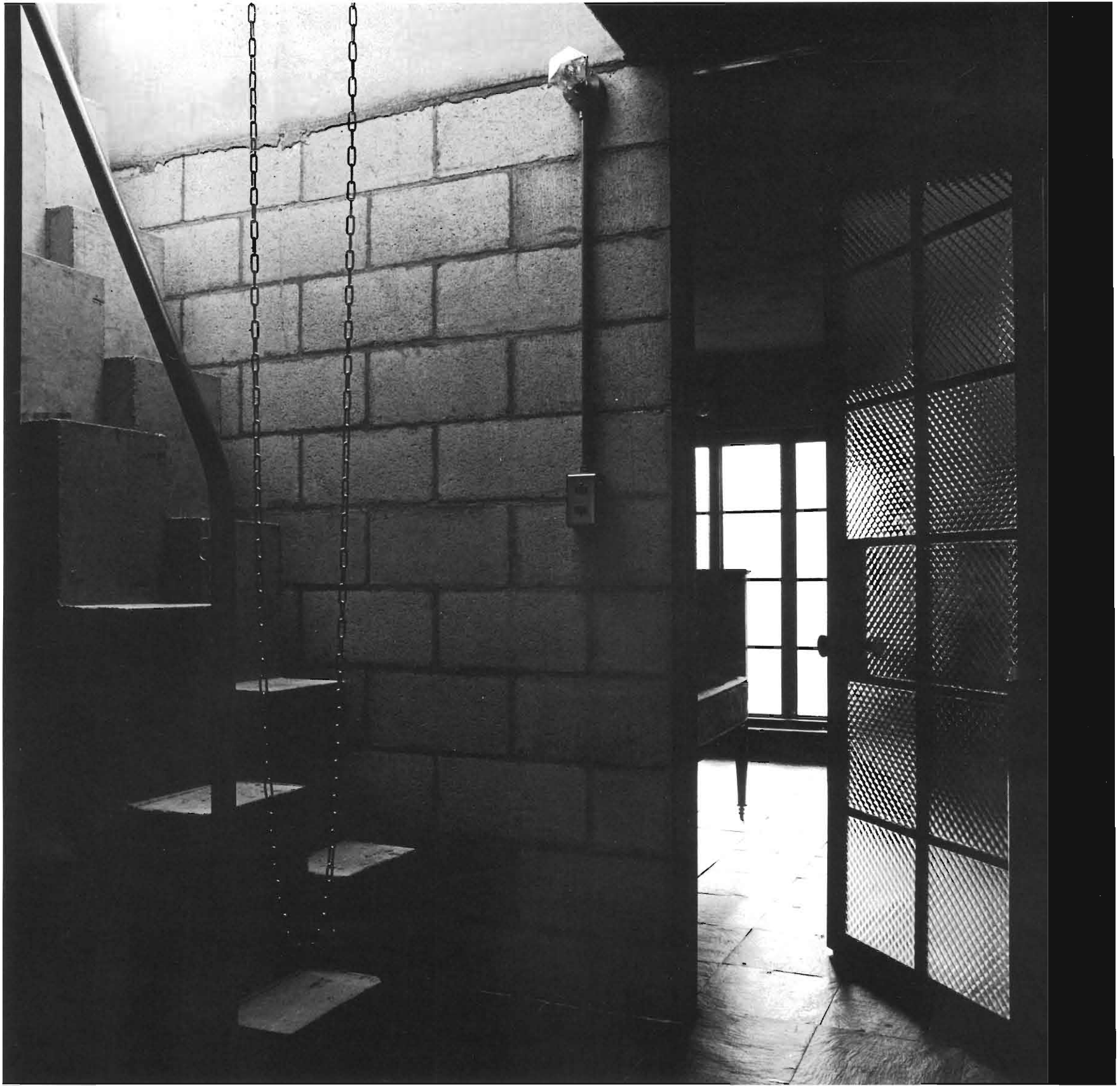
3階廊下 左は屋上へのステップ
