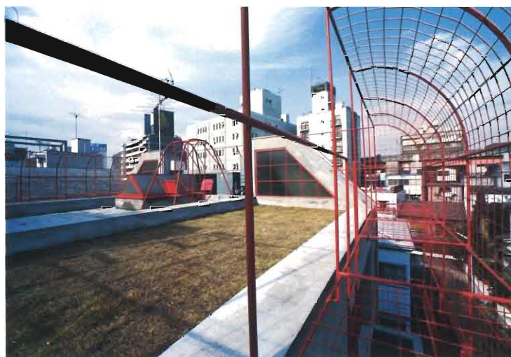
屋上庭園とプラントネットを見る
